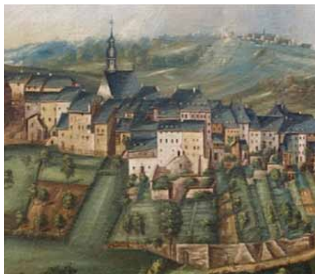
Détail après restauration
